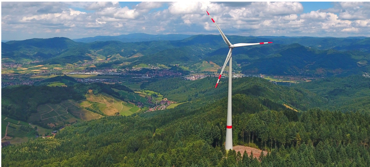
Abbildung 11: Anlage im Windpark Rauhkasten/Steinfirst, Ortenaukreis (Baden-Württemberg)
