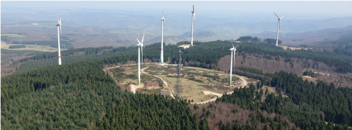
Abbildung 29: Windpark Kandrich auf ehemals militärisch genutztem Standort im Landkreis Bad Kreuznach (Rheinland-Pfalz)
