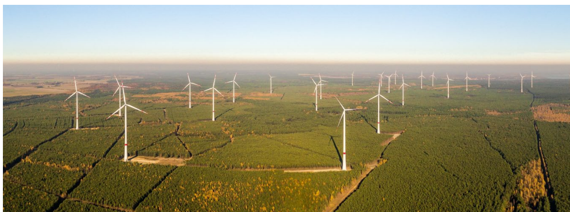
Abbildung 18: Windpark Chransdorf West im Landkreis Oberspreewald-Lausitz (Brandenburg)
